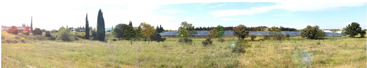
Photomontage du projet dans la perspective d'une dérogation avec la mise en place de mesures d'accompagnement et de plantation de haies - © ATER Environnement
